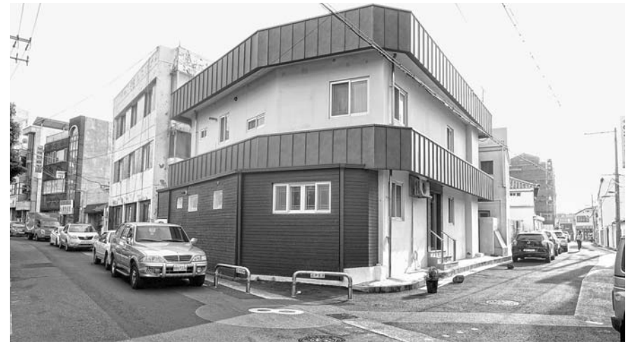
도로 확장 공사가 끝난 후 양방향 통행 이면도로로 변경된 도로(오른쪽 방향). 김현석기자
