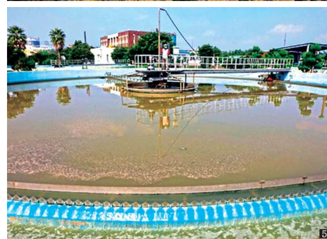
1 서부하수처리장 2 서부하수처리장 항공사진 3 동부하수처리장 4 제주하수처리장 5 하수처리장 침전지, 사진-제주도 제공
