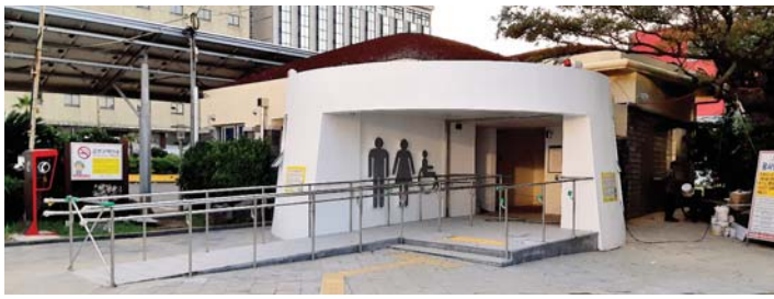
유니버설 디자인을 적용해 리모델링한 탐동 제2공원 화장실.
