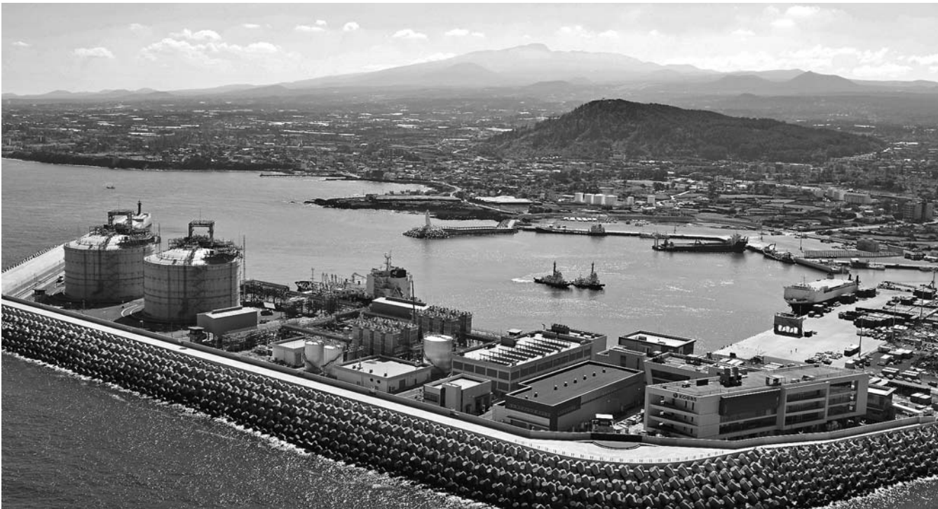
24일 LNG 수송선 SM JEJU LNG 1호 (3300t급)가 처음으로 입항한 제주시 애월항 한국가스공사 LNG인수기지.
