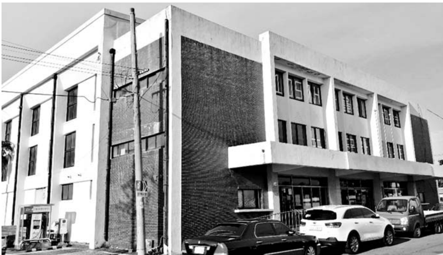
이달부터 철거에 들어가는 서귀포시민회관 전경.
