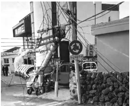
>> 사진 이 사고로 인명피해는 없었지만 전봇대 4개가 부러졌으며, 부러진 전봇대에 차량 4대가 깔려 파손되기도 했다.
