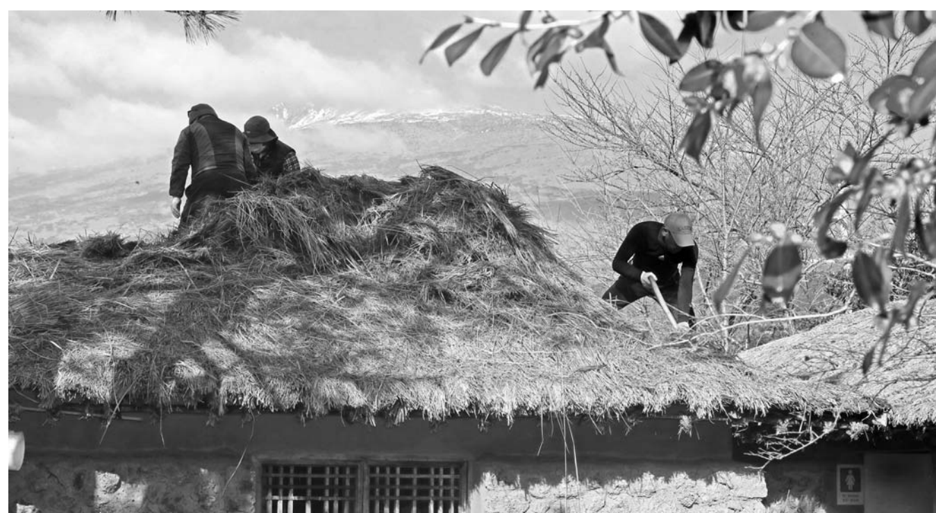
제주 초가지붕 잇기 9일 오전 서귀포시 남원읍 휴애리자연생태관광공원에서 작업자들이 초가지붕을 잇고 있다. 제주 사람들은 바람에 잘 견디고 습기에 강한 재료인 새(띠)를 촘촘히 덮은 뒤 집줄을 바둑판 모양으로 얹어 매 강한 비·바람을 이겨내 왔다. 연합뉴스
