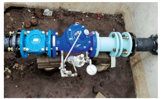
상수도망 블록 구축과 배·급수관로 시설 현대화 사업 현장.
