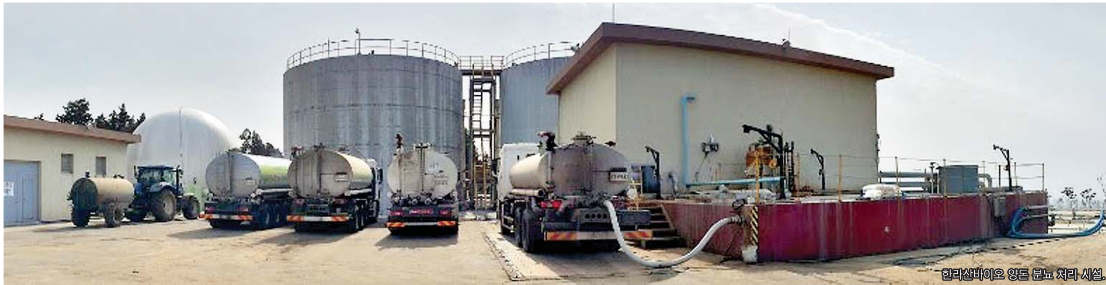
한라산바이오 양돈 분뇨 처리 시설.
