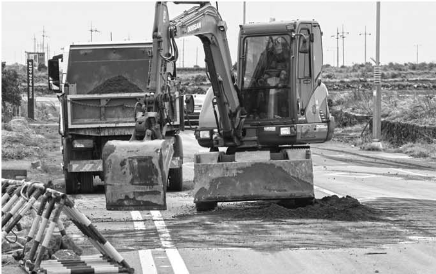
태풍이 지나간 흔적들... 제11호 태풍 '힌남노'가 제주를 핏돌던 6일 서귀포시 대정읍 신도포구에 있던 어선이 전복되는 피해를 입었다(사진 맨 위). 대정읍 해안도로 인근 월파피해를 입은 농경지(두 번째). 태풍이 물러간 뒤 파손된 해녀 밭의 장 시설물을 치우고 있는 표선면 세화리 해녀들(세 번째)과 중장비가 동원돼 정비중인 서귀포 해안도로(맨 아래). 강희만·이상국기자
