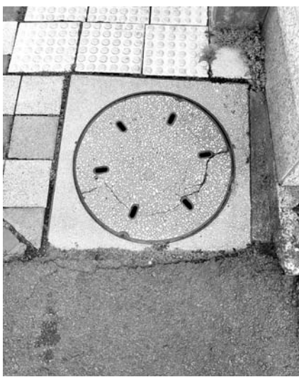
제주시 소재 모 초등학교 인근에 설치된 콘크리트 재질의 맨홀 뚜껑.
