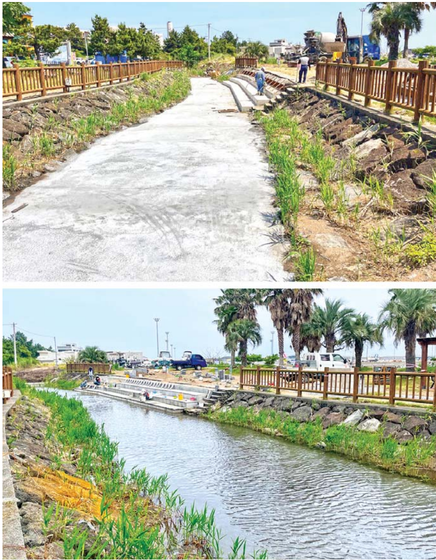
용천수를 빼고 콘크리트로 매운 바닥(사진 위·제주환경운동연합 제공)과 16일 공사를 위해 막았던 물길을 다시 열면서 콘크리트로 매운 바닥 위로 용천수가 흐르는 모습. 양유리기자
