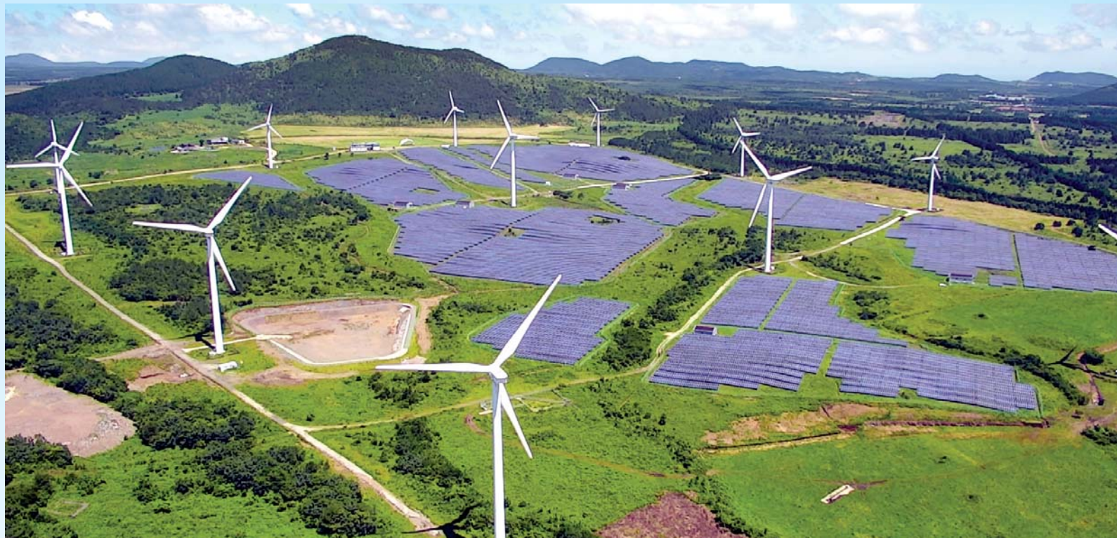
서귀포시 표선면 가시리마을공동목장에 설치된 풍력발전기와 태양광 발전시설 모습.
